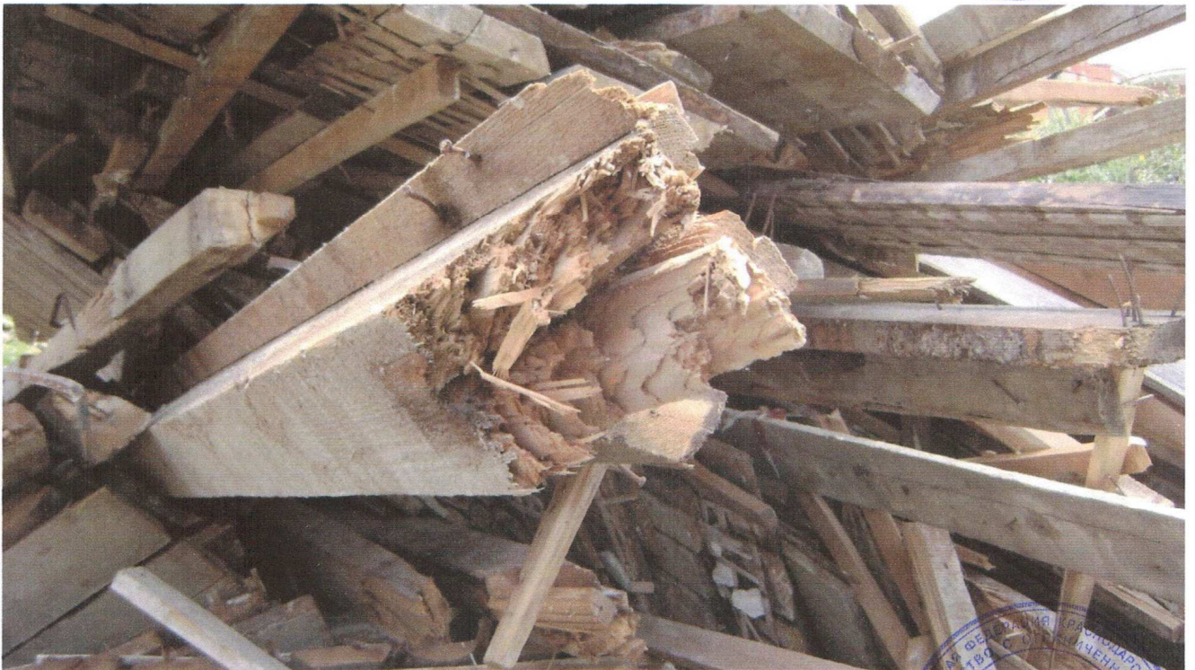
Фото №30. Деревянные конструкции потолочного покрытия и несущие элементы.
