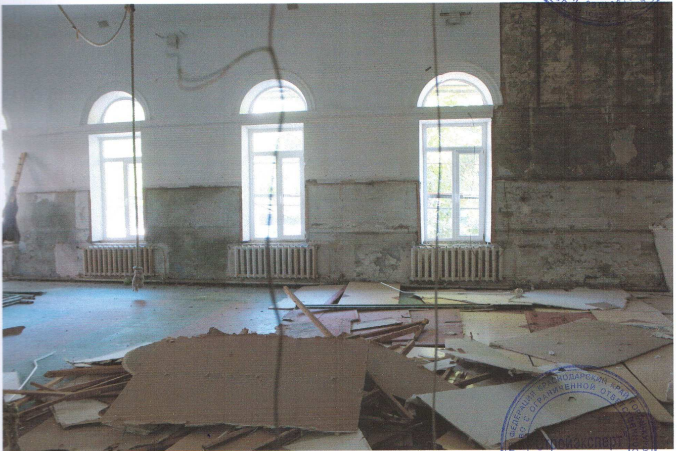
Фото №36. Демонтированные панели стен из ламинированного ДСП и обивка стен из листов ГКЛ.
