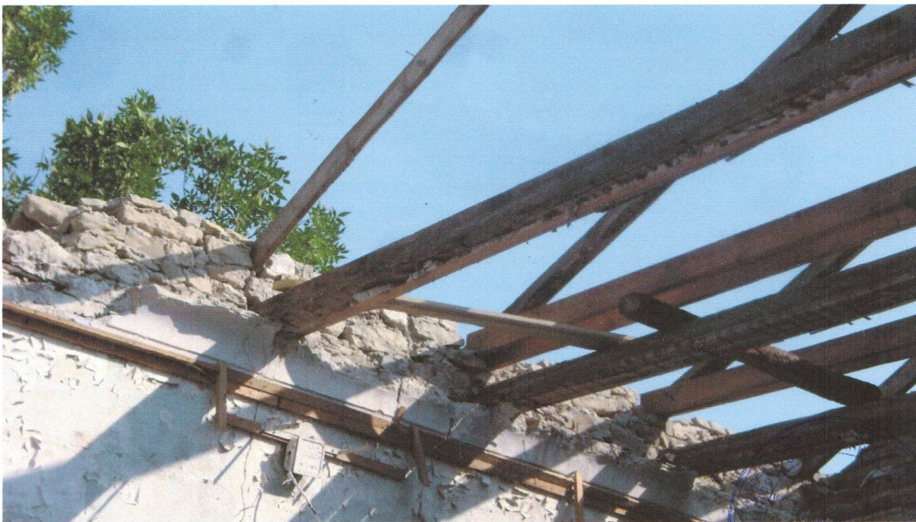
Фото №21. Опираение деревянных ферм на наружные стены.
