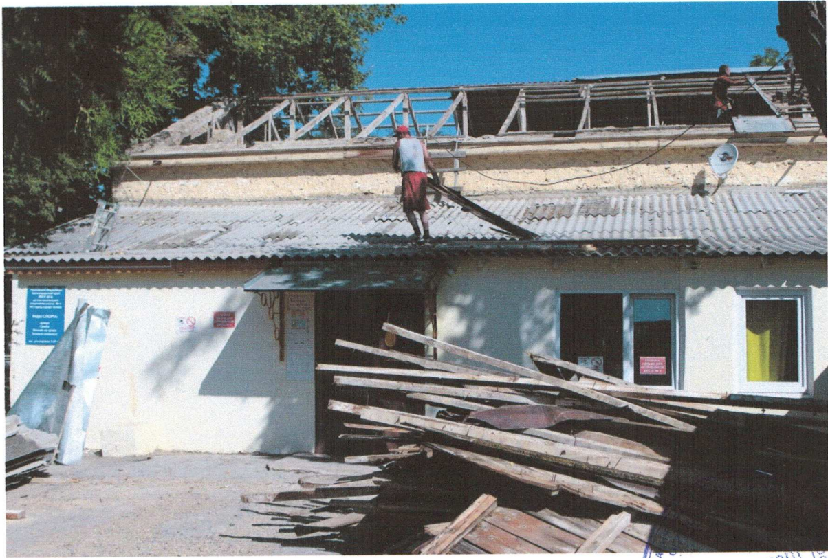
Фото №9. Разборка конструкции кровли.
