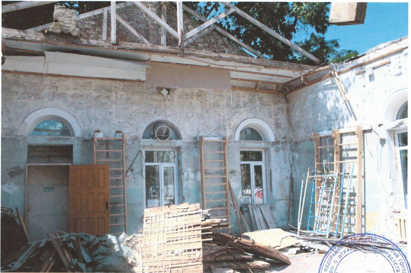
Фото №15. Здание спортивного зала после начала производства ремонтных работ съемка июль 2014 года.
