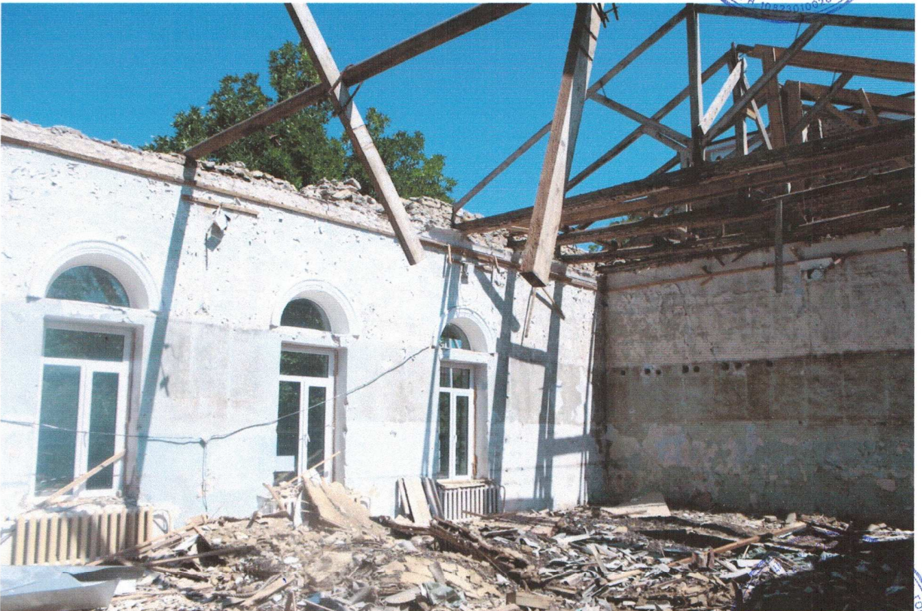
Фото №14. Здание спортивного зала после начала производства ремонтных работ съёмка июль 2014 года.
