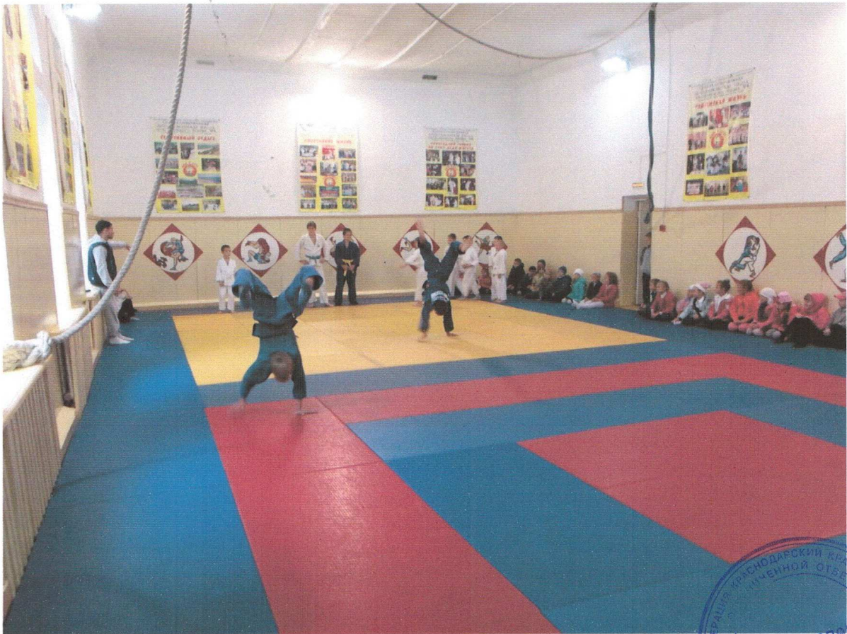
Фото №7. Помещение спортивного зала до проведения ремонтных работ, съемка апрель 2014 год.
