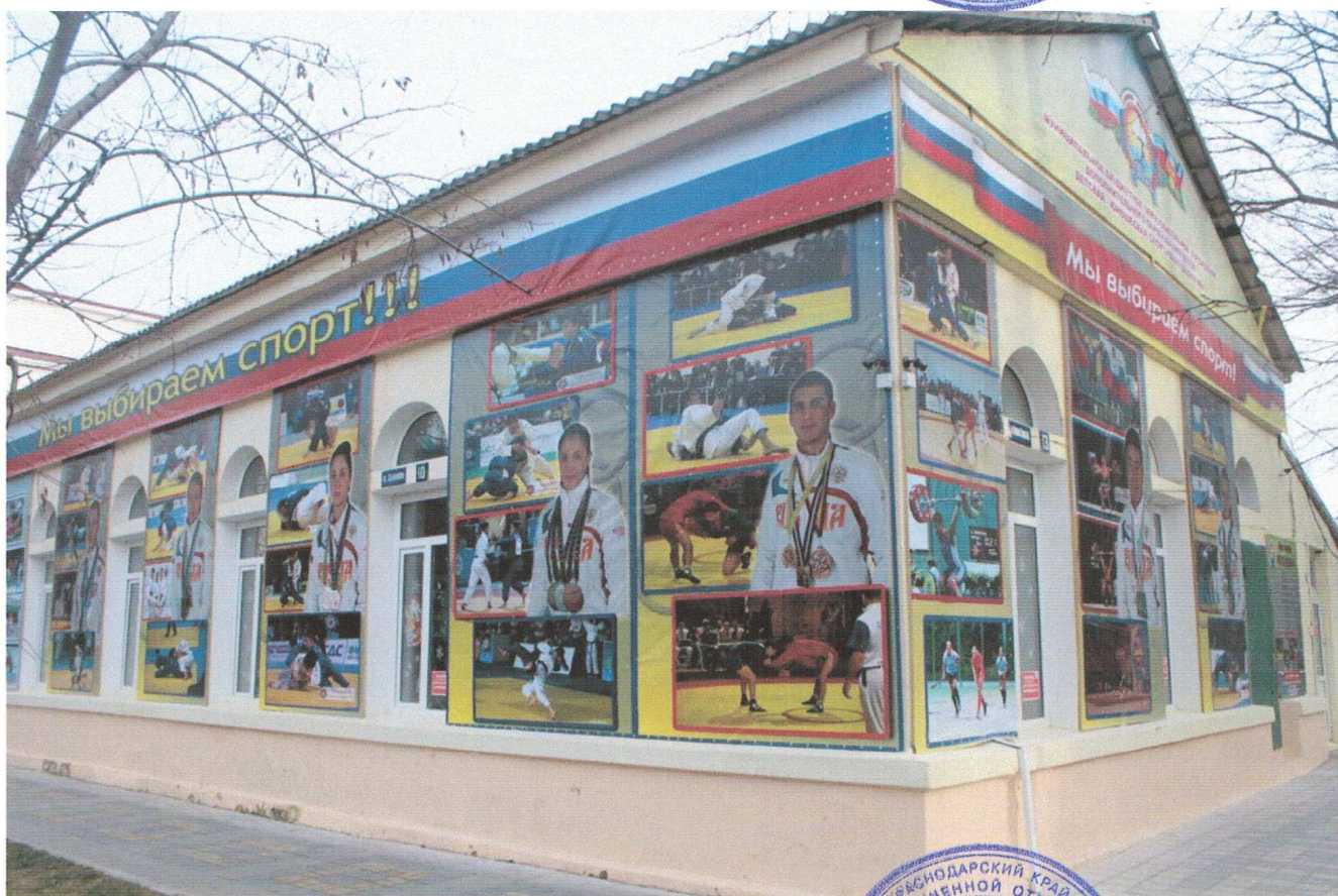
Фото №2. Здание спортивного зала до проведения ремонтных работ, съемка апрель 2014 года.
