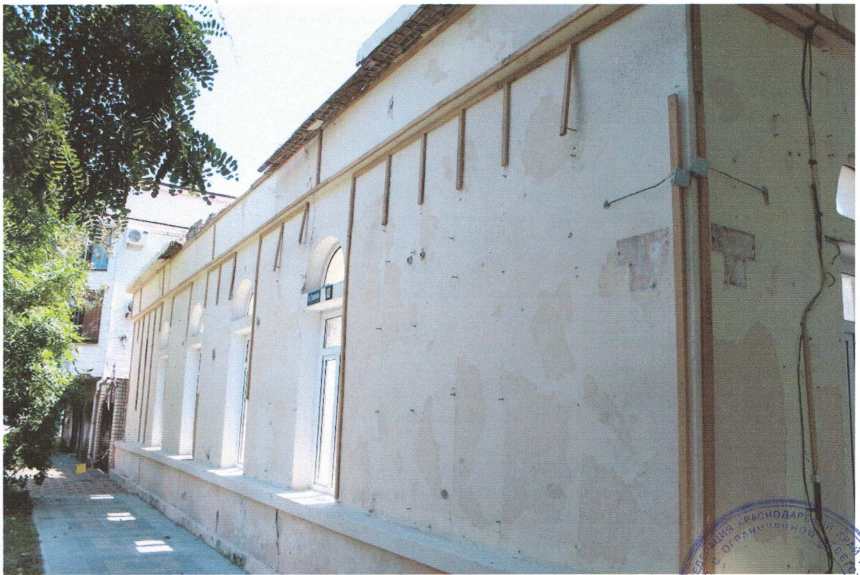
Фото №11. Здание спортивного зала после начала производства ремонтных работ съемка июль 2014 года.
