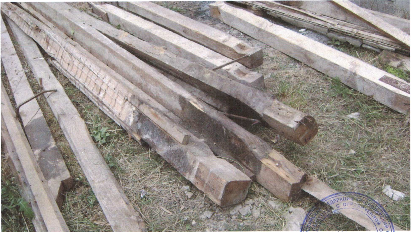
Фото №31. Деревянные элементы несущих ферм
