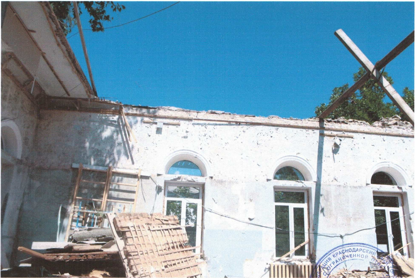
Фото №13. Здание спортивного зала после начала производства ремонтных работ съёмка июль 2014 года.
