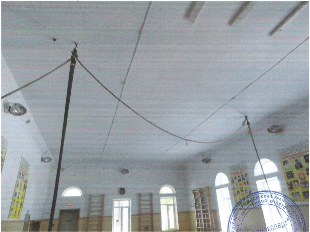
Фото №5. Помещение спортивного зала до проведения ремонтных работ, съемка апрель 2014 год.
