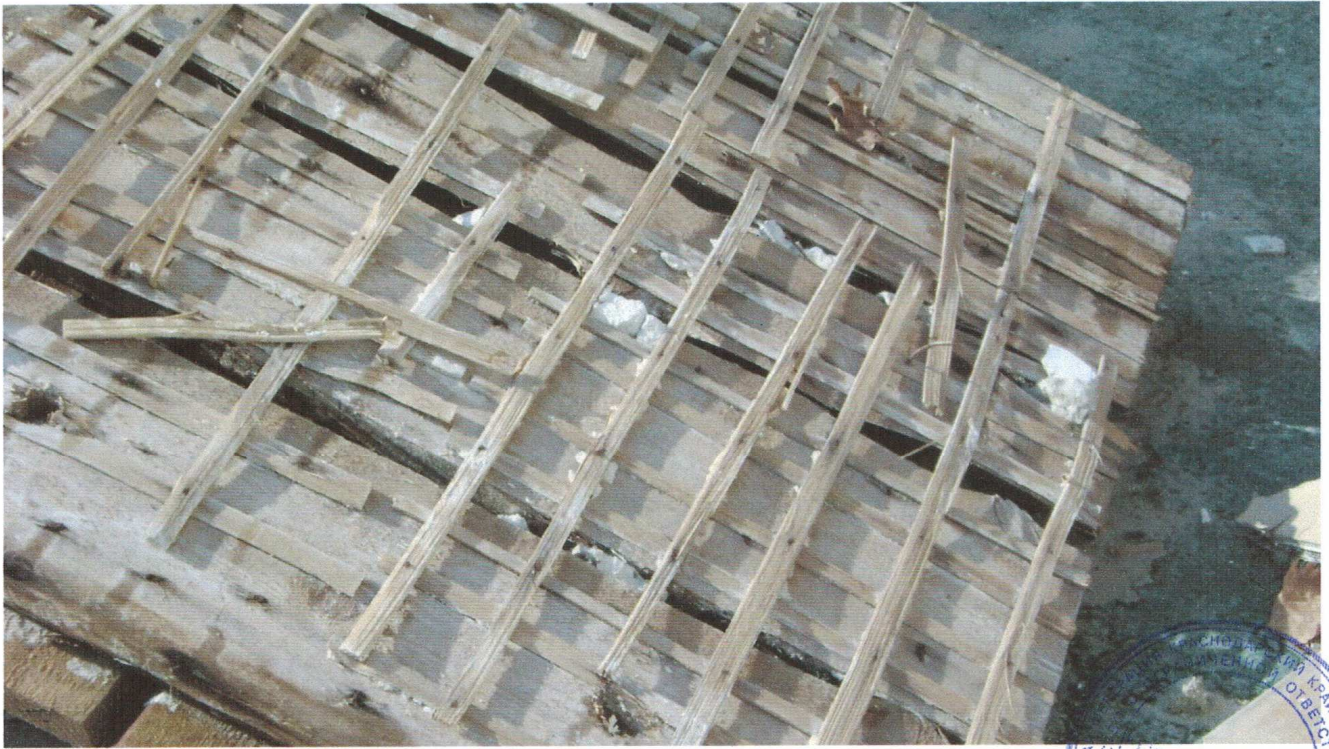
Фото №23. Деревянные щиты потолочного перекрытия.
