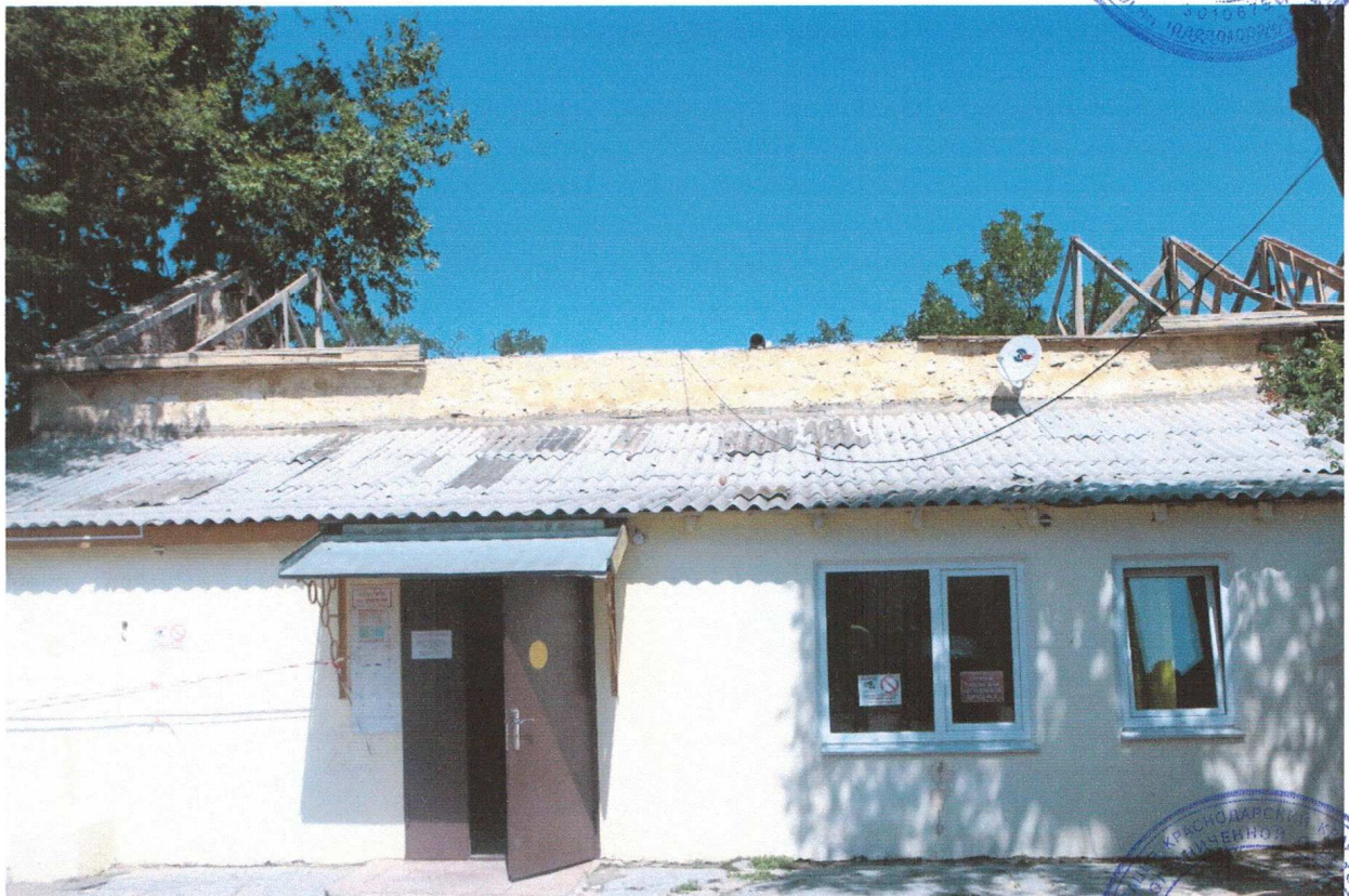
Фото №12. Здание спортивного зала после начала производства ремонтных работ съемка июль 2014 года.
