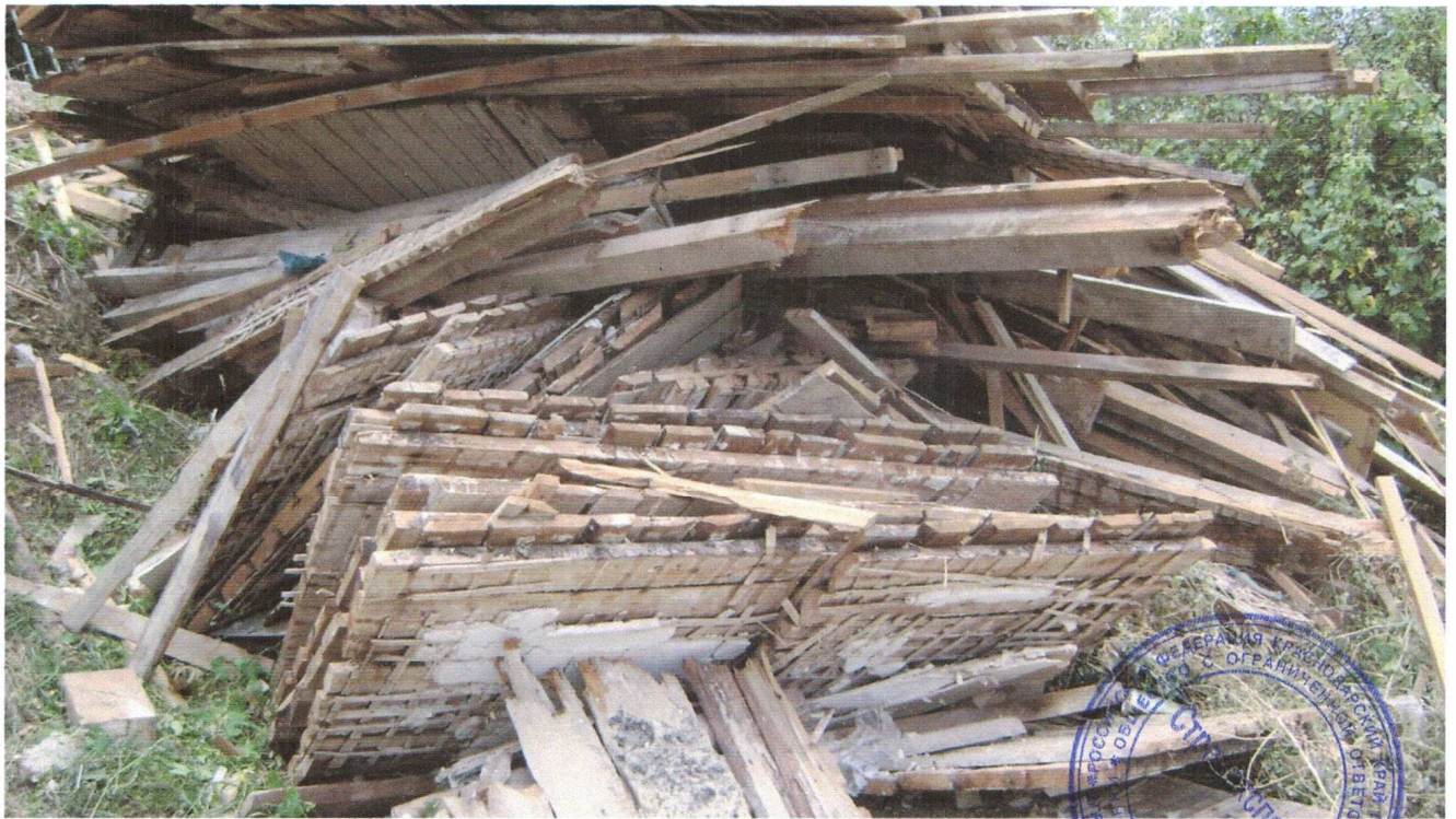
Фото №29. Деревянные конструкции потолочного покрытия и несущие элементы
