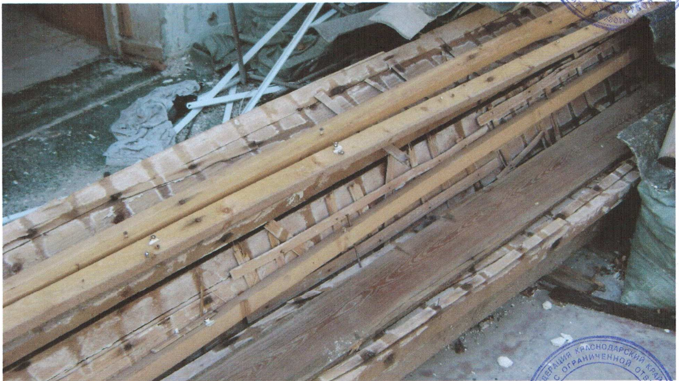
Фото №24. Несущие балки потолочного перекрытия.
