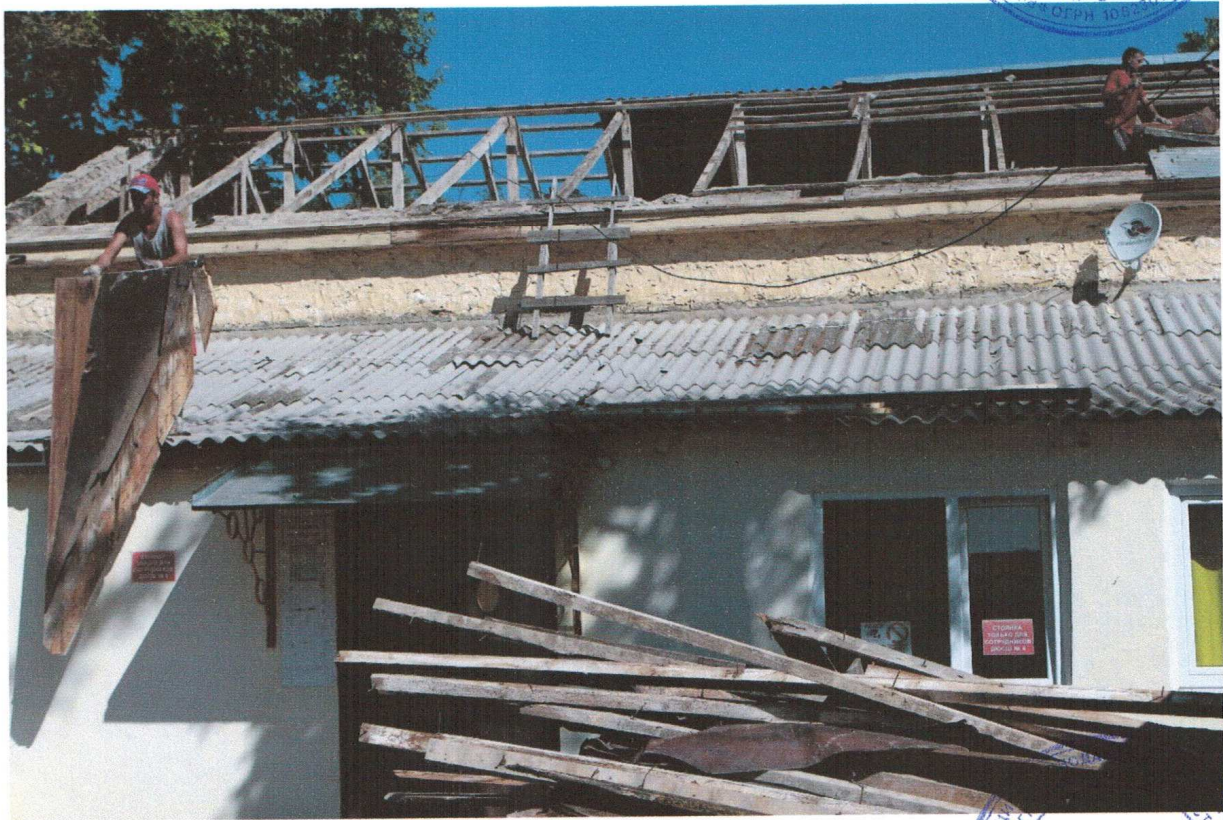
Фото №10. Разборка конструкции кровли.
