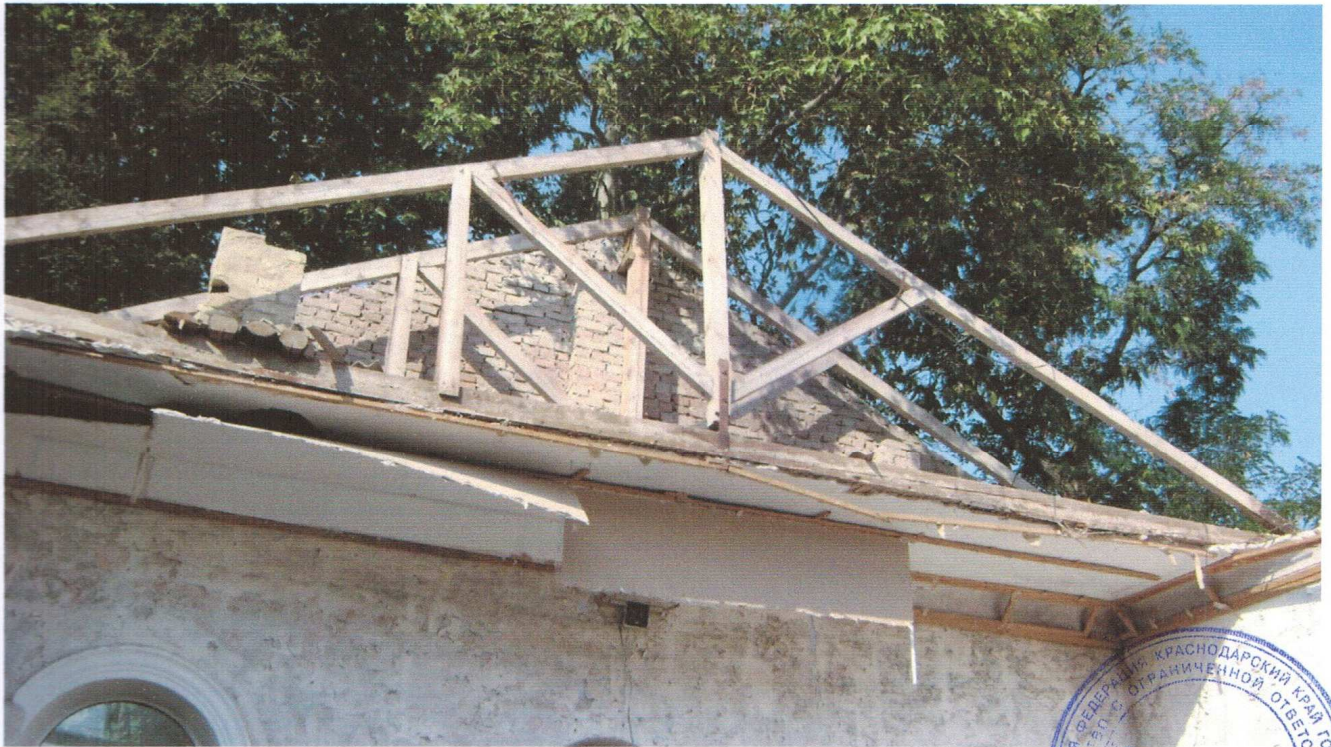
Фото №19. Несущая конструкция кровли-деревянная ферма.
