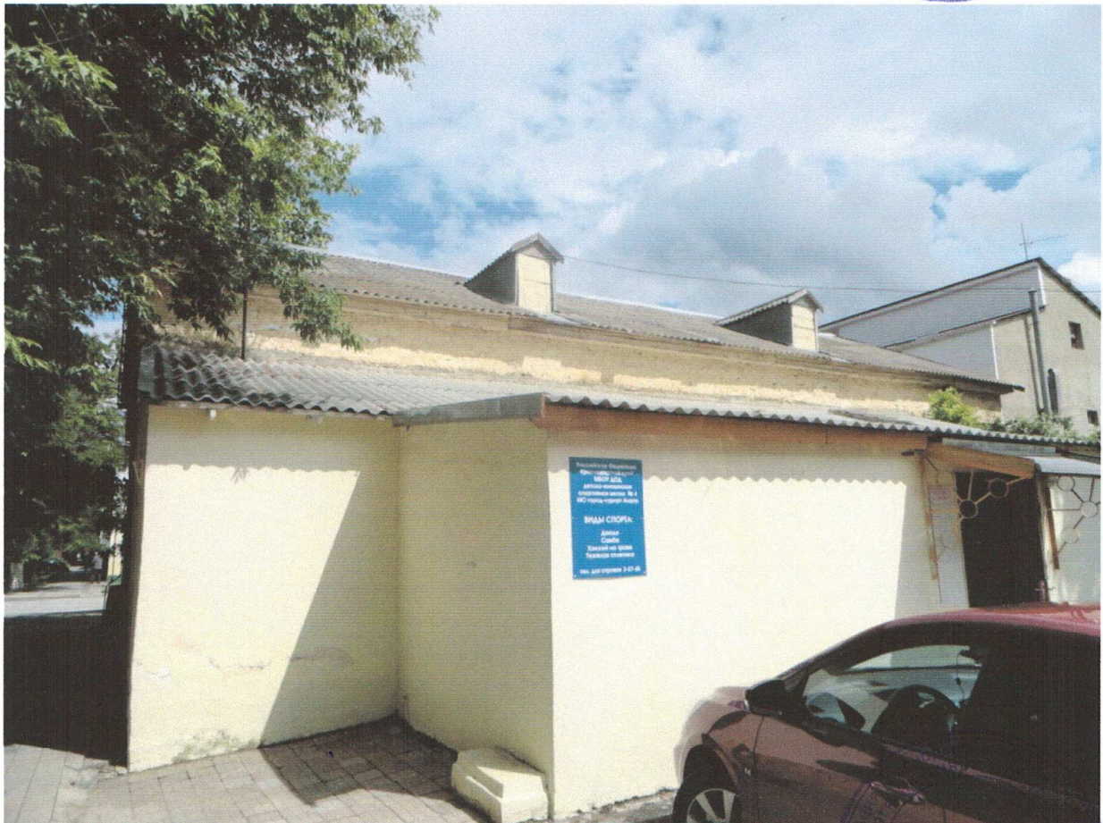
Фото №6. Здание спортивного зала до проведения ремонтных работ, съемка апрель 2014 года.
