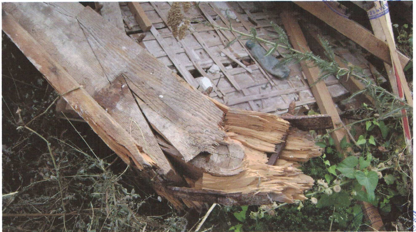
Фото №26. Место излома несущей деревянной балки.
