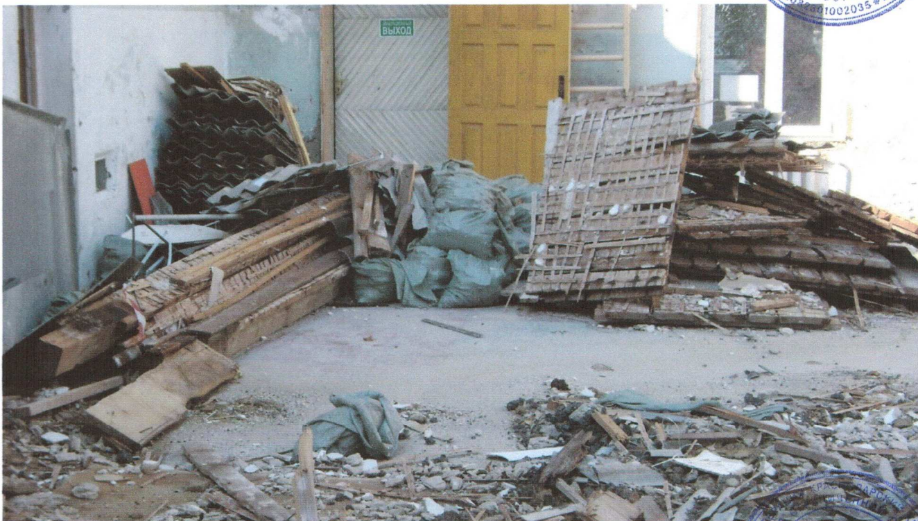
Фото №22. Конструкции деревянного перекрытия.
